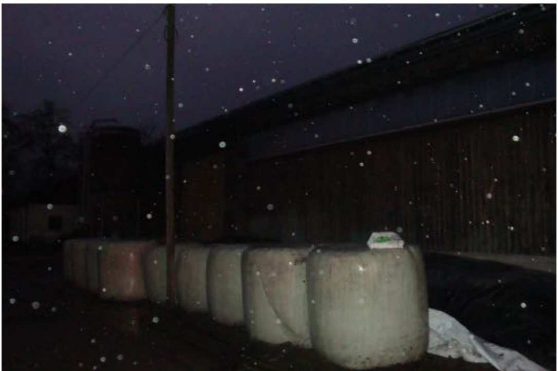
Stallgebäude von außen (Silage)
